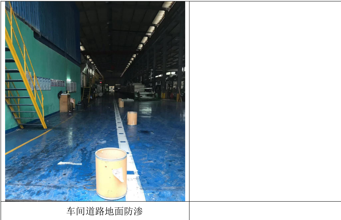
图 5-3 防渗措施现场图
