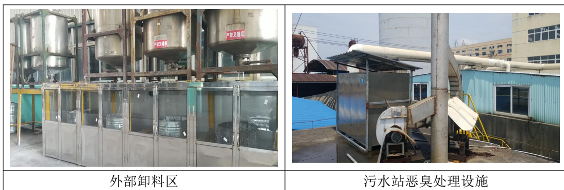
图 5-3 部分废气处理设施现场图
