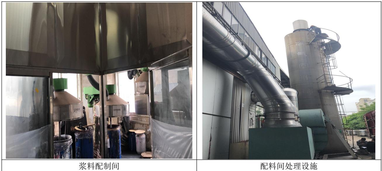
图 6-5 项目废气收集治理现场情况图
