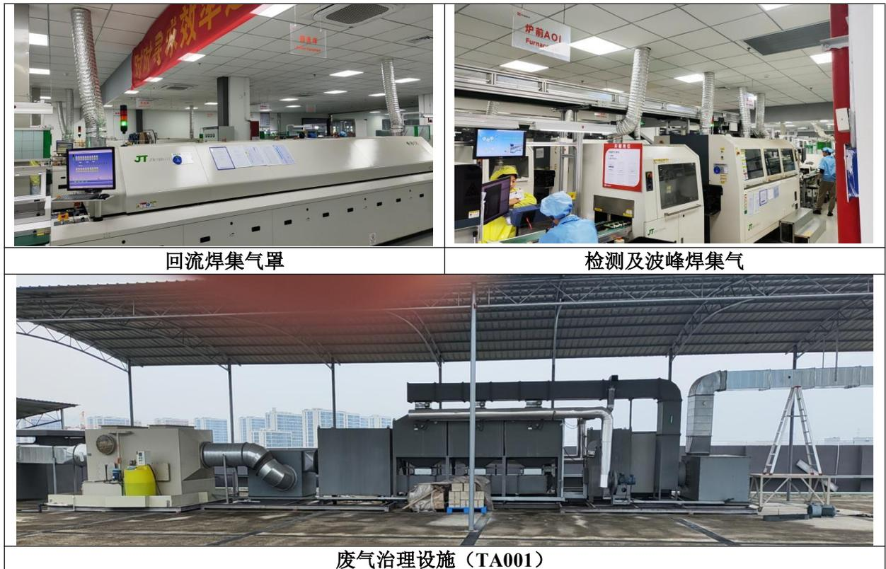
图 3-1 废气产污结点和处理设施现场图
